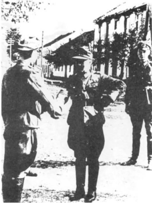
General von Krosigk besichtigt den Brückenkopf Neustadt jenseits des Ostflusses bei Schirwindt.
